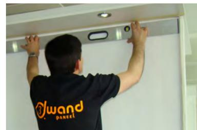
Nun teilen Sie mit Hilfe von Bleistift und Zollstock die zu beklebende Wand für die Wandpaneele ein. Die Wasserwaage nutzen Sie dabei als Hilfswerkzeug bei der exakten Unterteilung für die entsprechende Paneel-Größe.
