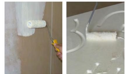
Jetzt tragen Sie den 3D Wand Spezialkleber mit dem Roller an die Wand auf und lassen diesen 30-60 Minuten trocknen. Nach der 30-60 minütigen Trocknungszeit tragen Sie den Kleber auch auf die Rückseite der Paneele auf.
