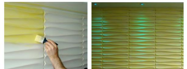
Die 3D Wandpaneele sind Naturprodukte und bestehen aus Bambusfasern und Zuckerrohr. Erfahrungsgemäß arbeiten Naturprodukte nach dem Anstrich weiter. Um dem vorzubeugen, grundieren Sie die Paneele vor dem Färben. Erwiesenermaßen erreicht man das beste Ergebnis durch die 3D Wand Spezialgrundierung. Diese Grundierung ist speziell für die 3D Wandpaneele entwickelt worden. Zum Auftragen der 3D Wand Spezialgrundierung auf die Paneele benutzen Sie bitte einen Pinsel.
